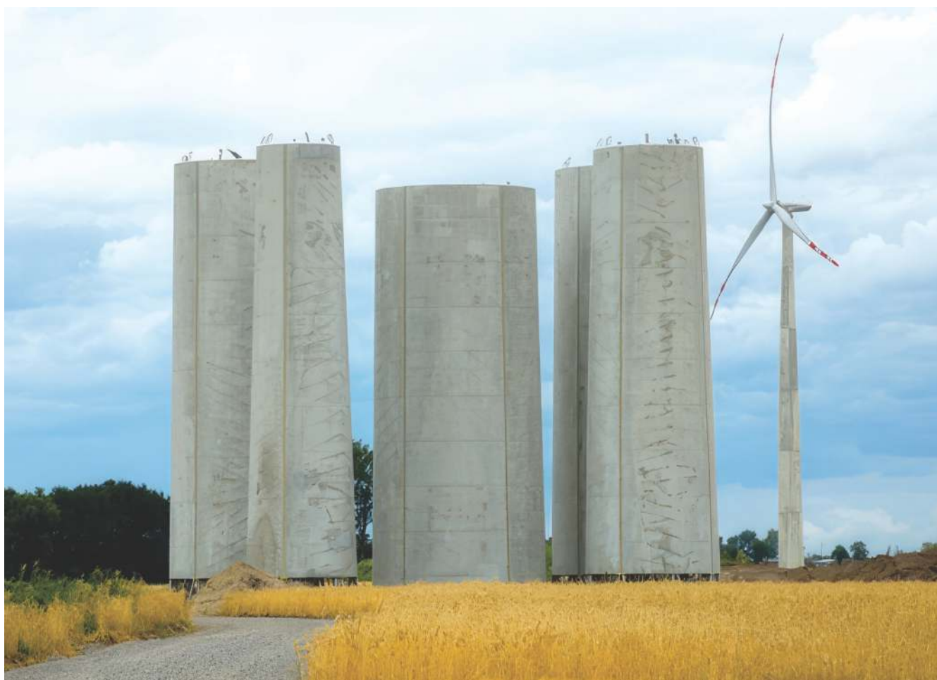
Rysunek 13 Żelbetowe wieże turbin wiatrowych
